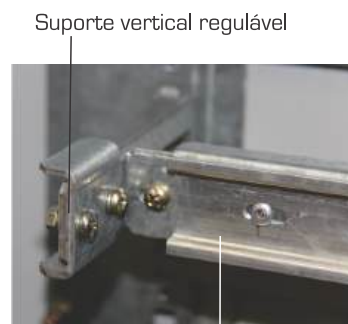
Suporte Horizontal com perfil DIN para fixar disjuntores bornes.
